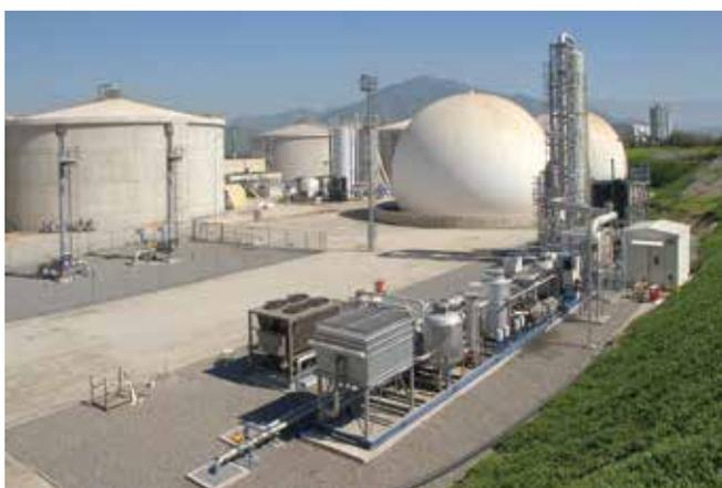
Анаэробные биореакторы и установки для очистки биогаза, установка по очистке сточных вод La Farfana (Сантьяго, Чили)
