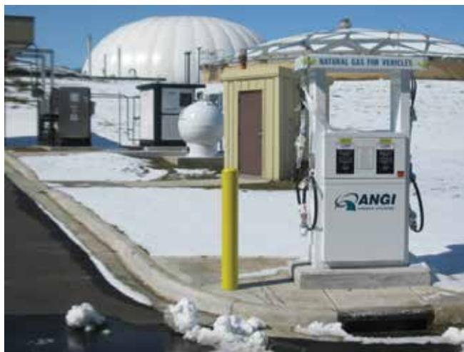
Проект переработки биогаза из сточных вод в автомобильное топливо (сжатый природный газ), установка по очистке сточных вод Japessville (Джейнсвилль, шт. Висконсин, США)
