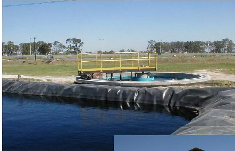
→ Pileta aeróbica y sedimentador
