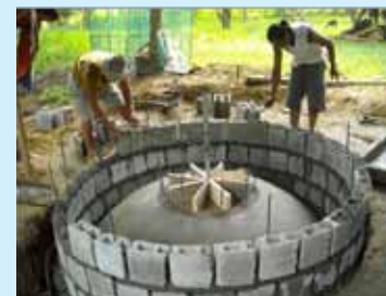
Construcción de un digestor de domo fijo apilado en Nueva Vizcaya, Filipinas
