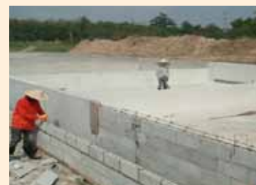
Construcción de un digestor en la granja Phanus Amporn en Tailandia
