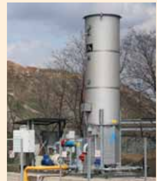
Quemador de gas de vertedero en funcionamiento en el Vertedero de Mariupol, Ucrania
