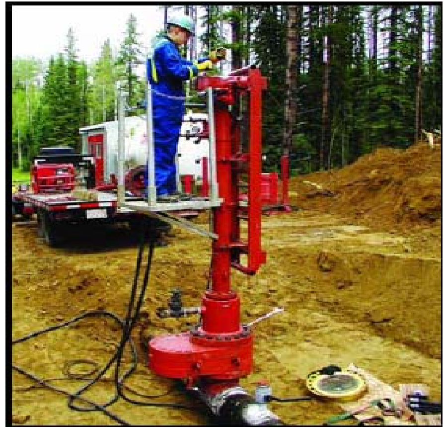
Técnico certificado de Williamson Industries realizando una conexión “hot tap” con una máquina de conexiones durante la aplicación de un tapón de 12 pulgadas
