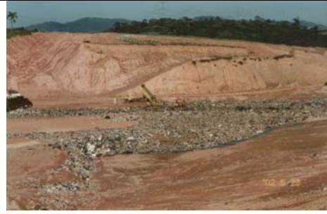
Foto 1. Vista geral da frente de operação do Aterro Pajoan, em Itaquaquetuba, SP.
