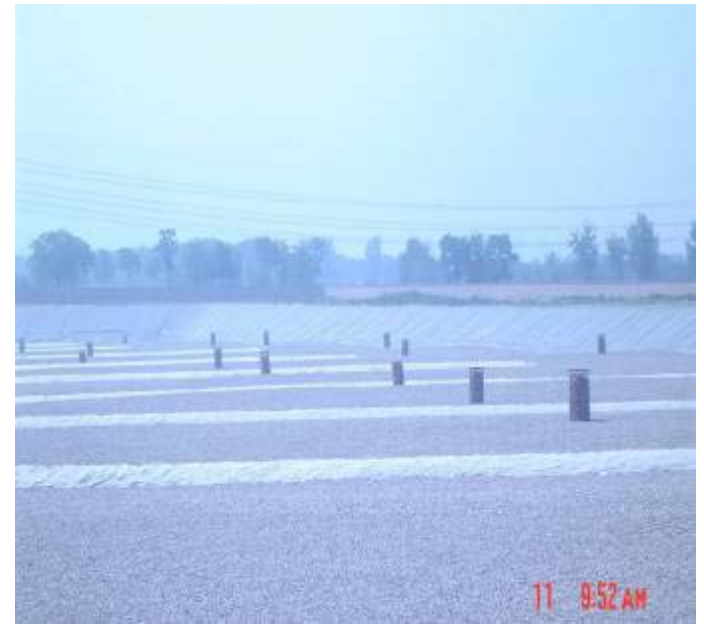
铺设完毕的填埋场
