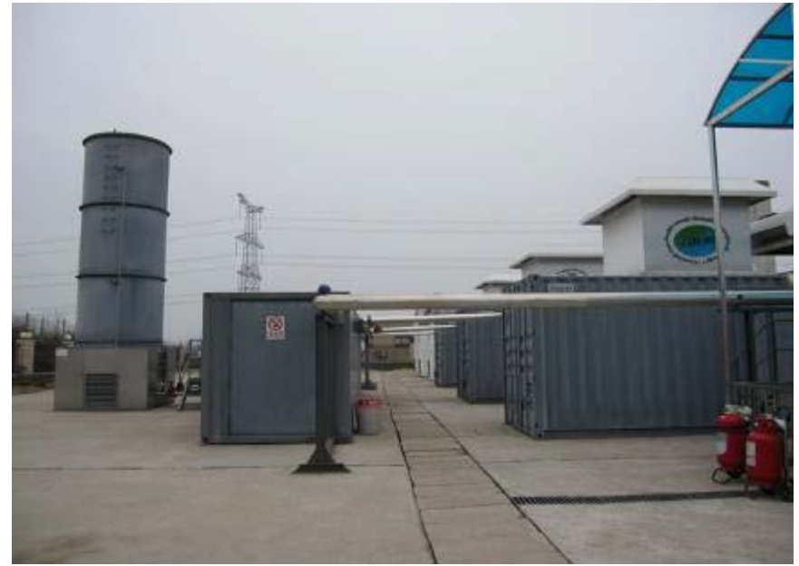
武汉陈家冲垃圾填埋场
