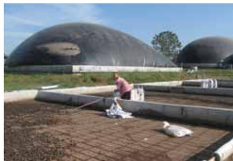
Анаэробный биореактор. На первом плане — яма для сбора сухих твердых отходов (Таиланд)
