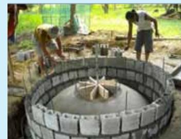
*Строительство стационарно-купольного биореактора штабельного типа в Нуэва-Виска, Филиппины*
