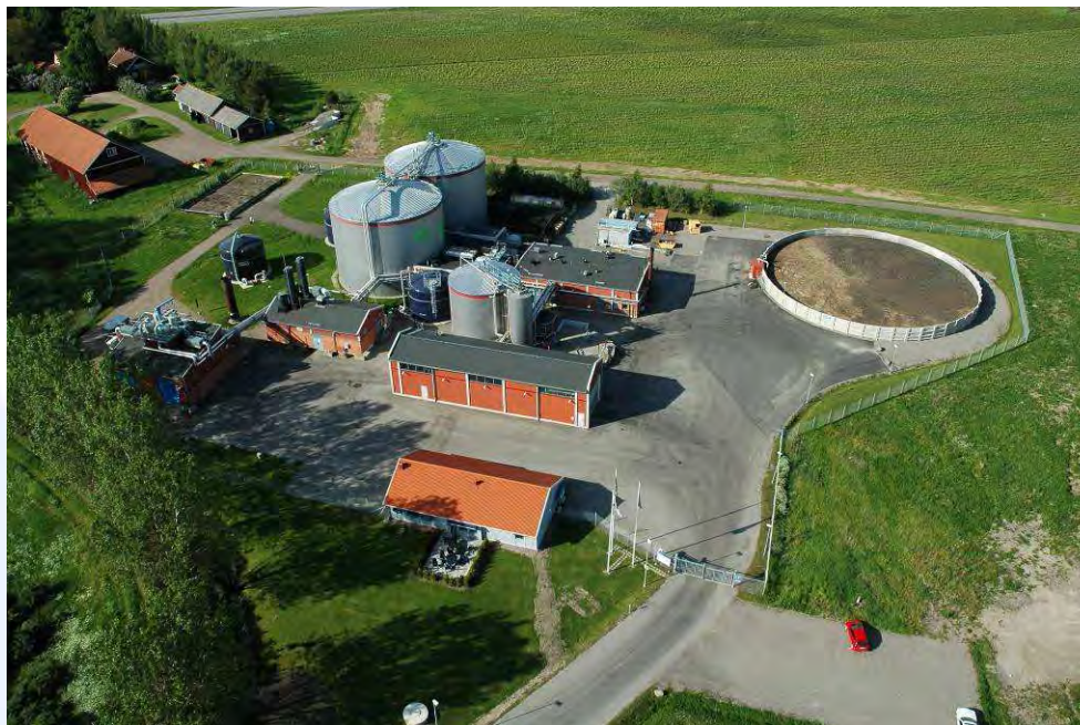
Svensk Biogas Ab Photo: Lasse Heidenberg
